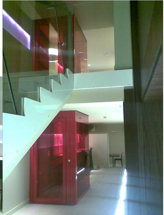
Cet appareil certifié avec une nacelle est conçu suivant la norme NF EN 81-41 et la directive machine 2006/42/CE.
